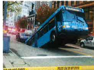
ピッツバーグ市内陥没事故 (2019/11)
