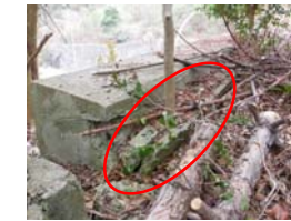
パラペット端部排水溝の破損
