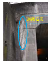
パラペットのひび割れ、漏水
