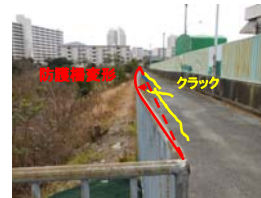
法面上部舗装ひび割れ、防護柵変形
