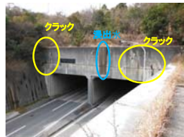
坑口全景（クラック、浸出水状況）
