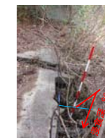
のり砕工空洞化
