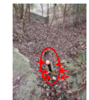
縦排水溝の破損（圧壊）
